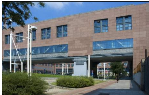
Strutture dell'ampliamento del Politecnico di Torino. 2010 Fonte: MuseoTorino
