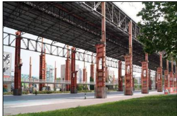
Tettoia di Parco Dora 2015
