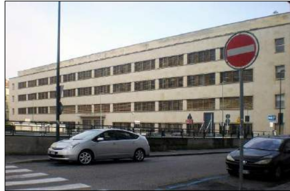
Edificio riusato per centro medico, oggi in disuso 2015
