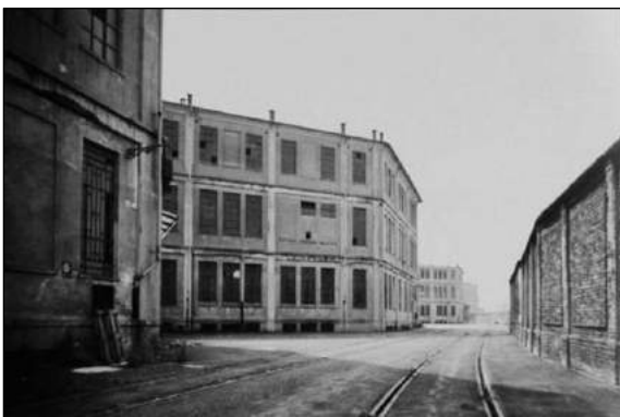
Ex magazzini Docks Piemontesi
