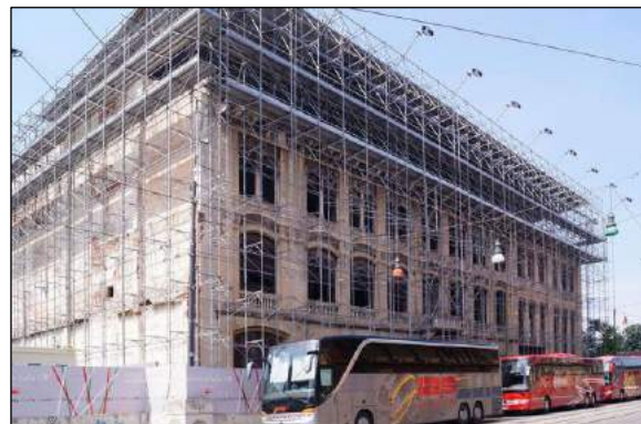
Edificio dismesso e cantiere
