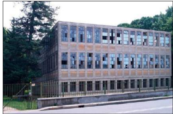
Edificio abbandonato e vandalizzato 2015
